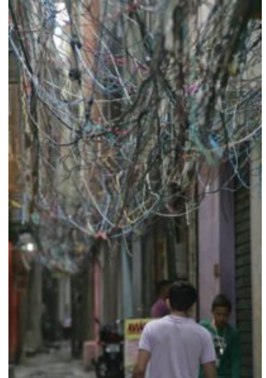
Instalações clandestinas de energia – “gatos” 1
